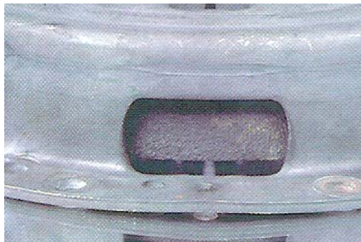
Montaggio errato del meccanismo
