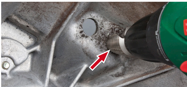
Снимка 5: Пробиване на отворите
